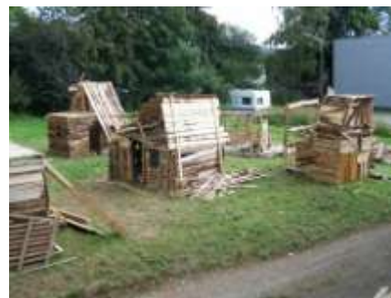
Viele Hütten sind von außen fast ausschließlich mit Schwarten getäfelt.
